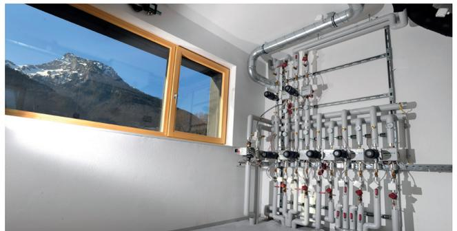
Um die Effizienz der Bauteilaktivierung mit Beton in der Praxis zu testen, untersuchte das Netzwerk zwei Jahre lang das Raumklima in einem bauteilaktivierten Simulationsraum in Salzburg. Jetzt liegen die Ergebnisse vor und diese sind sowohl beim Heizen, als auch beim Kühlen mit Beton eindeutig positiv ausgefallen.
