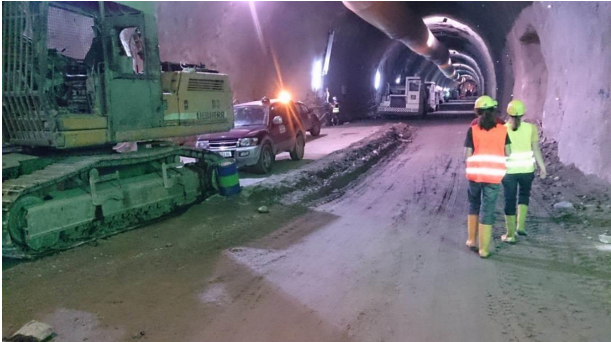
Abbildung 1: Tunnelbaustelle Gleinalm: Gleichzeitiger Einsatz von Mensch und Maschine (Quelle: VIRTUAL VEHICLE Research Center)
