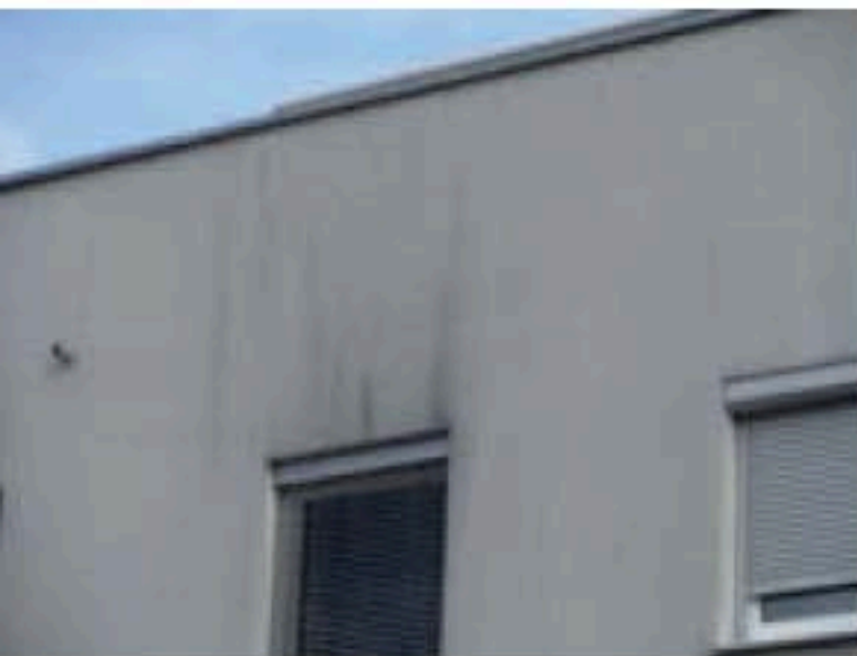
Ohne konstruktiven Schutz ist die Veralgung schnell feststellbar
